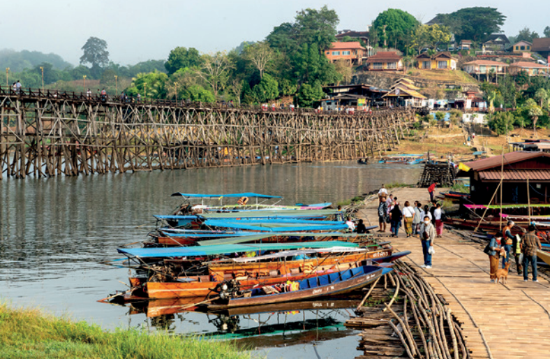
Le pont en bois de Sangkhlaburi
