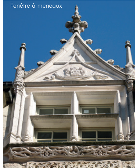
Fenêtre à meneaux
